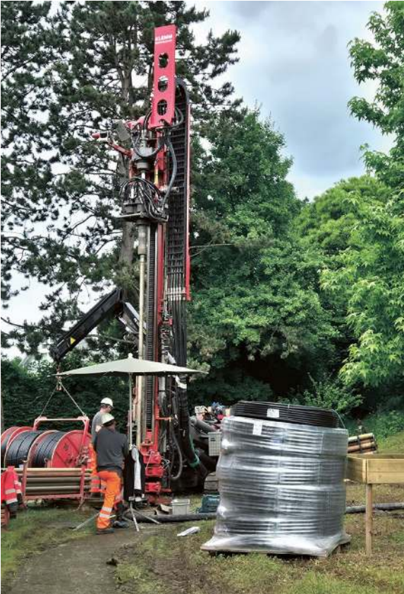
Erdsondenbohrung
