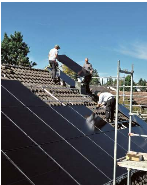
Platzierung der PV-Module
