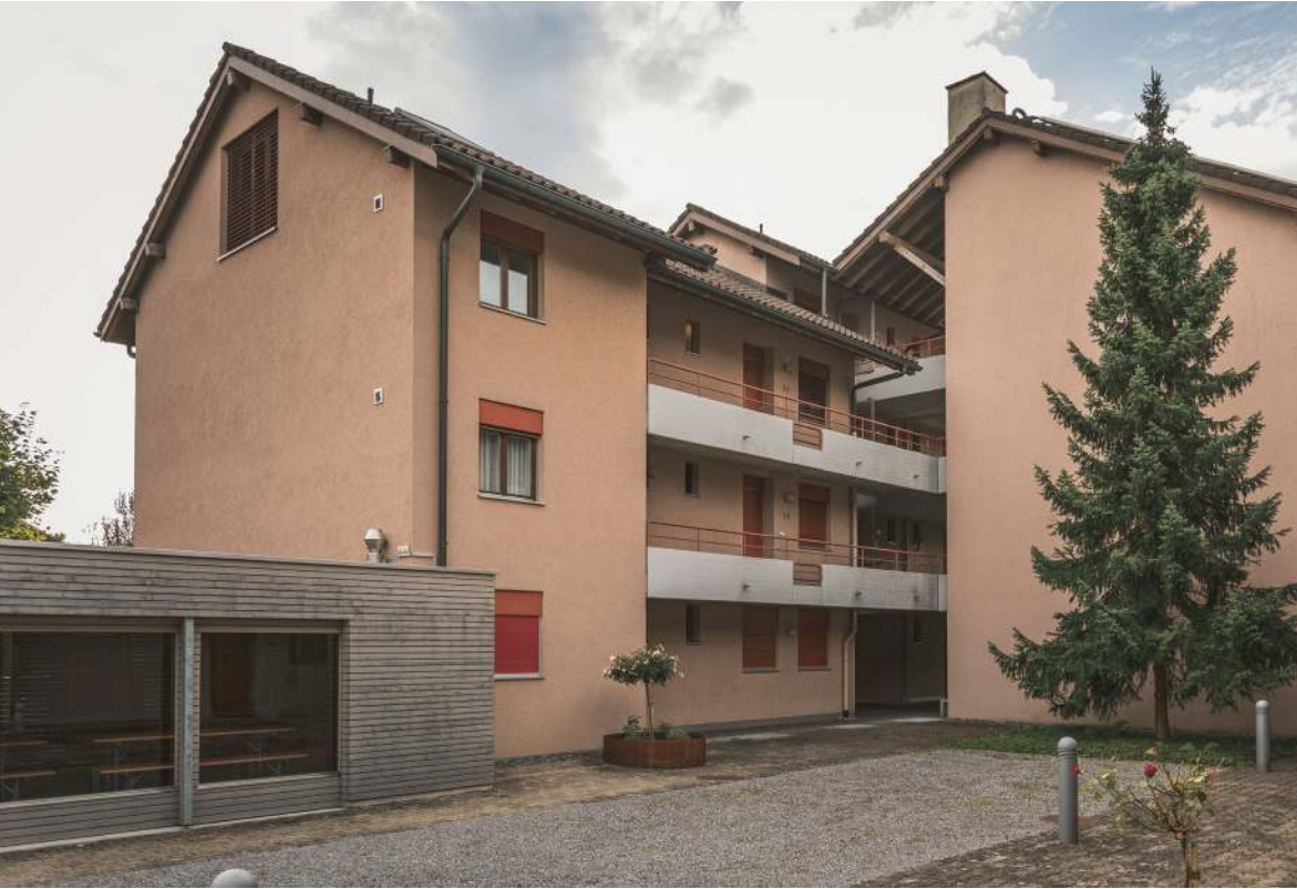
Die Liegenschaft Mugerenstrasse 5 – vor der Sanierung
