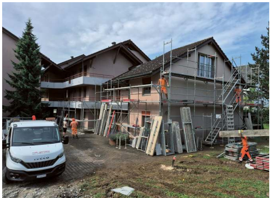
Aufbau der Gerüste
