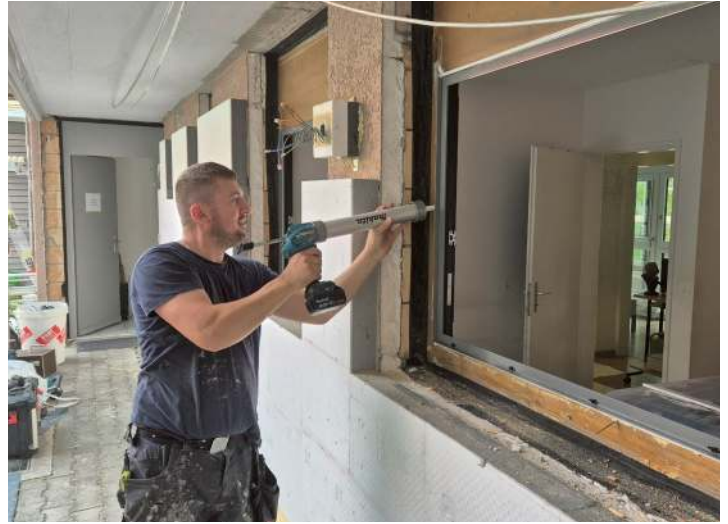
Anbringen von Silikonfugen bei den Fenstern
