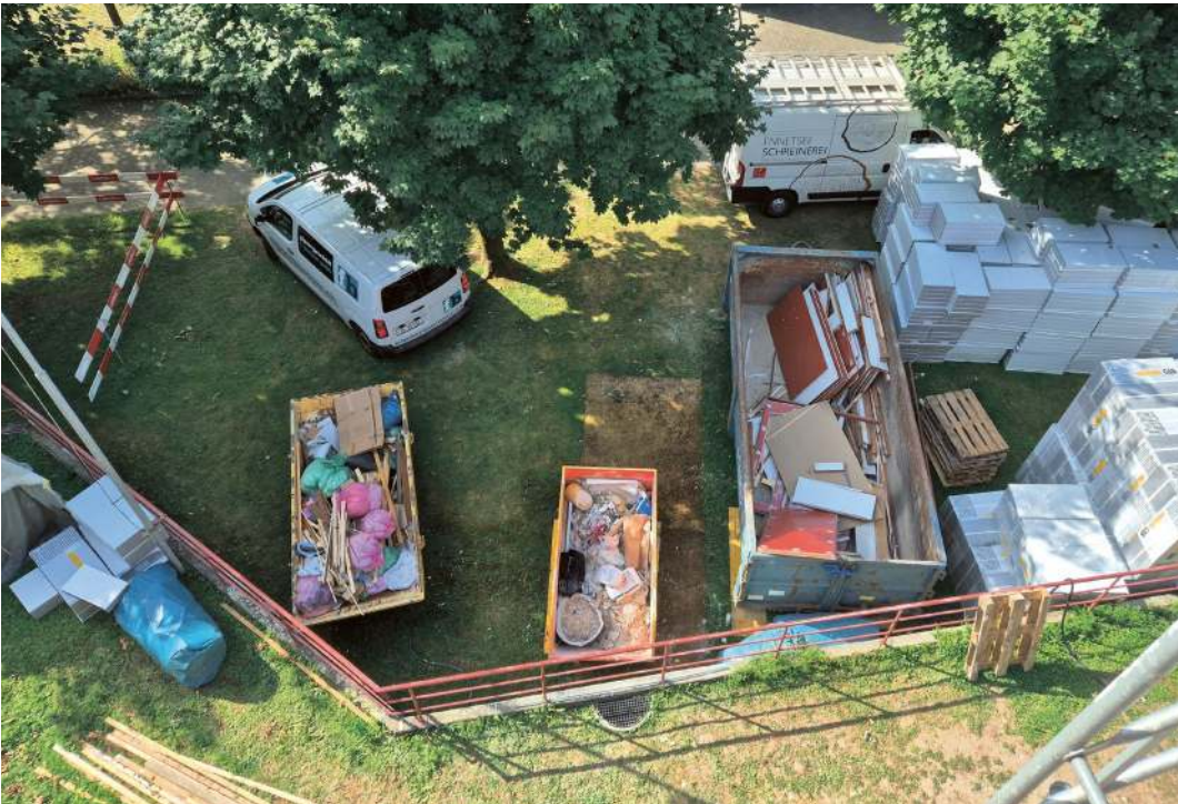
Baustellenplatz von oben
